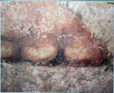
Piedras rojas del centro del muro oeste
