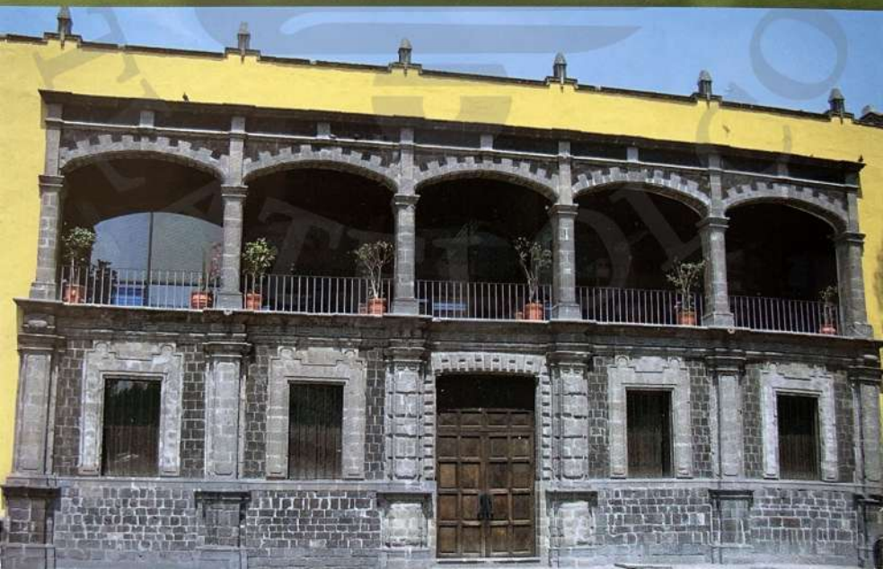
Fachada posterior del ex convento de Santiago
