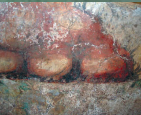
Piedras rojas del centro del muro oeste
